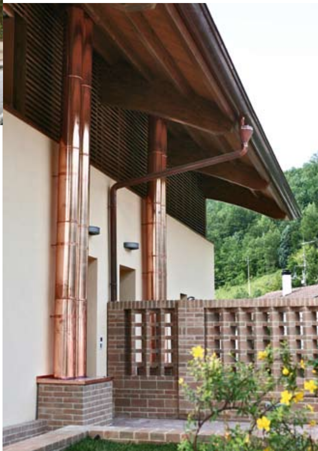
LA LEAF HOUSE È UNA PALAZZINA DI SEI APPARTAMENTI A IMPATTO ZERO. IN ALTO LA FACCIATA SUD CON I PANNELLI SOLARI (TERMICI E FOTOVOLTAICI) CHE FORNISCONO ACQUA CALDA ED ELETTRICITÀ. QUI SOPRA, I TUBI SOLARI CHE DISTRIBUISCONO LA LUCE DEL SOLE NEGLI ANGOLI PIÙ BUI DEGLI APPARTAMENTI.
