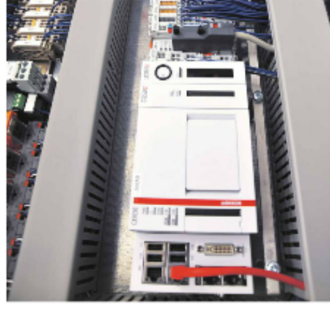
Il quadro di controllo con la soluzione Beckhoff
